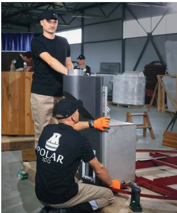
Установка печи на металлокаркас.
